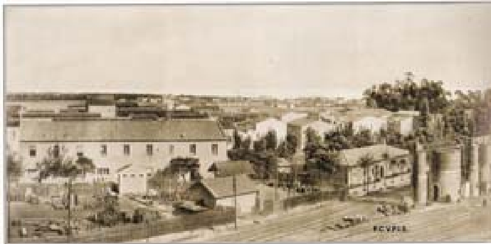
Foto: La Escuela vista por la fachada trasera en 1928.
